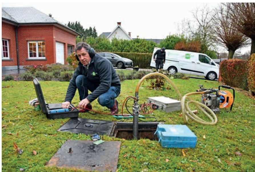
Fondateur de Certitank, Jacques de Lovinfosse compte une dizaine de milliers de contrôles d'étanchéité à son actif.
